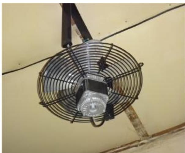
Вентилятор применяется для быстрого и равномерного прогрева отапливаемого помещения. Так же может применяться в быту для проветривания помещения.
